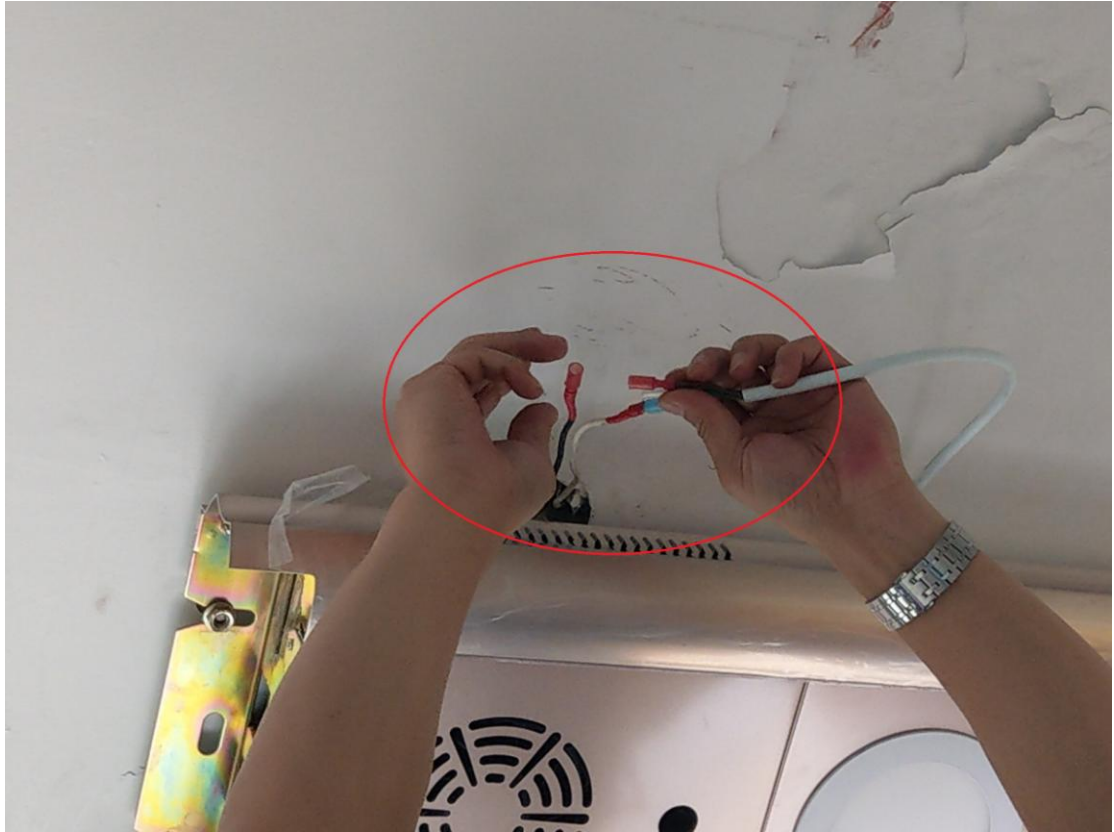
將電線快接公母頭接上.
