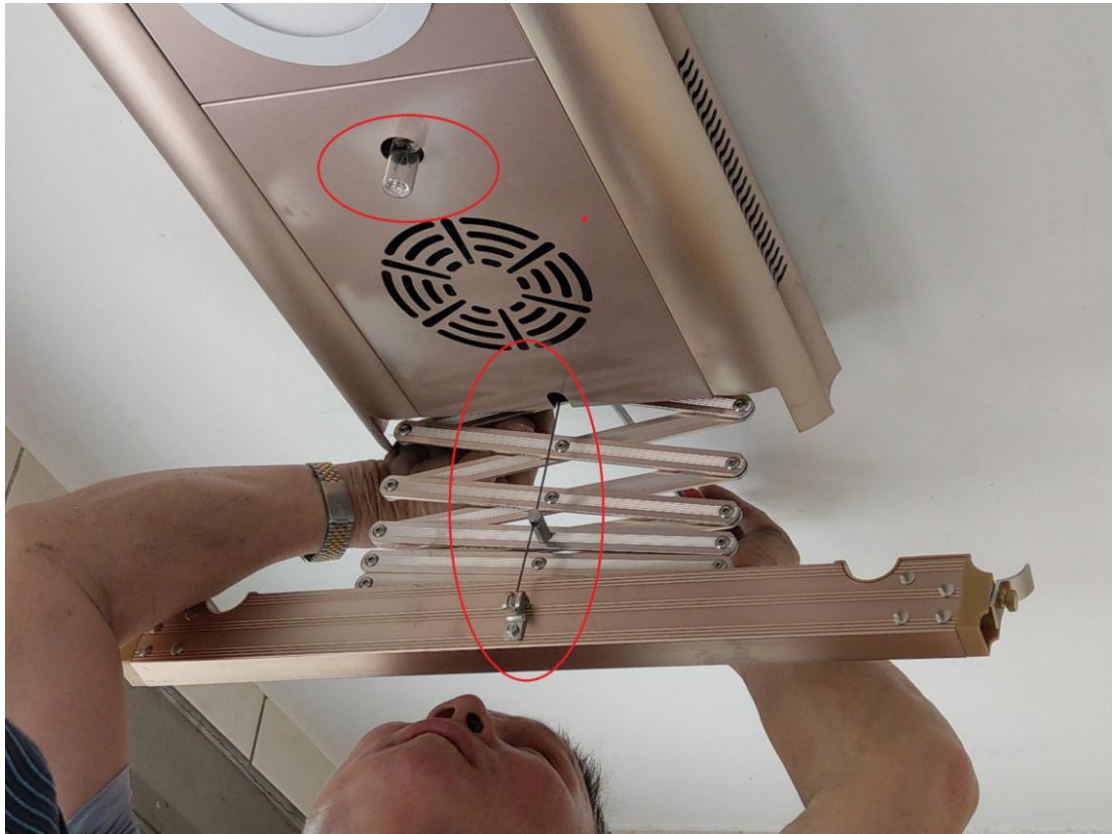
將左右鋼絲先穿過間間圓柱中的孔.最後在卡入槽內.並旋入紫外線燈.
