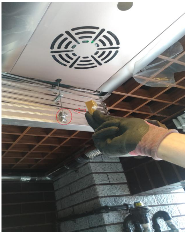
裝上左右鋼絲固定膠套
