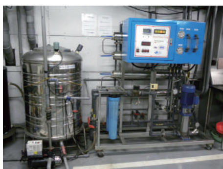
小型套裝RO水處理設備 Reverse Osmosis
