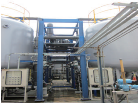
純水設備 Demineralization
