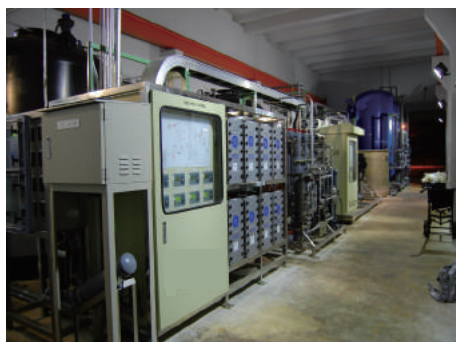
純水處理設備 Demineralization
