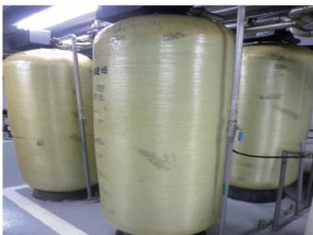
純水設備 Demineralization
